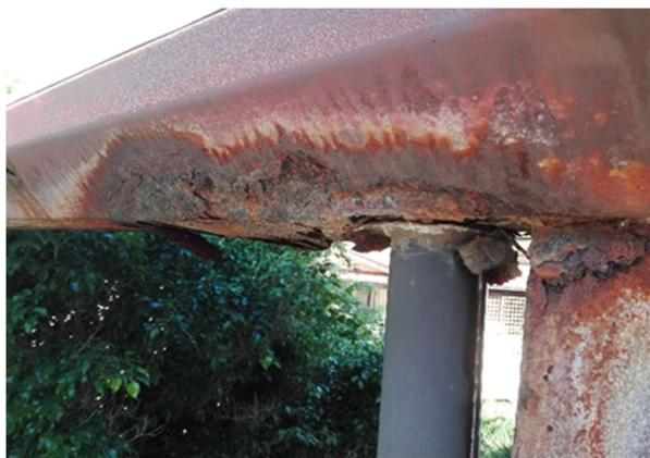
Fotografia 20 - Innesso canale di gronda - pluviale
