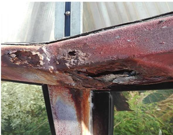
Fotografia 16 – Nodo canale di gronda - struttura portante della copertura della sala d'attesa
