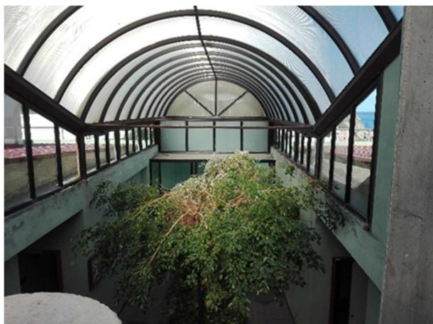
Fotografia 17 – Copertura leggera in acciaio e polycarbonato
