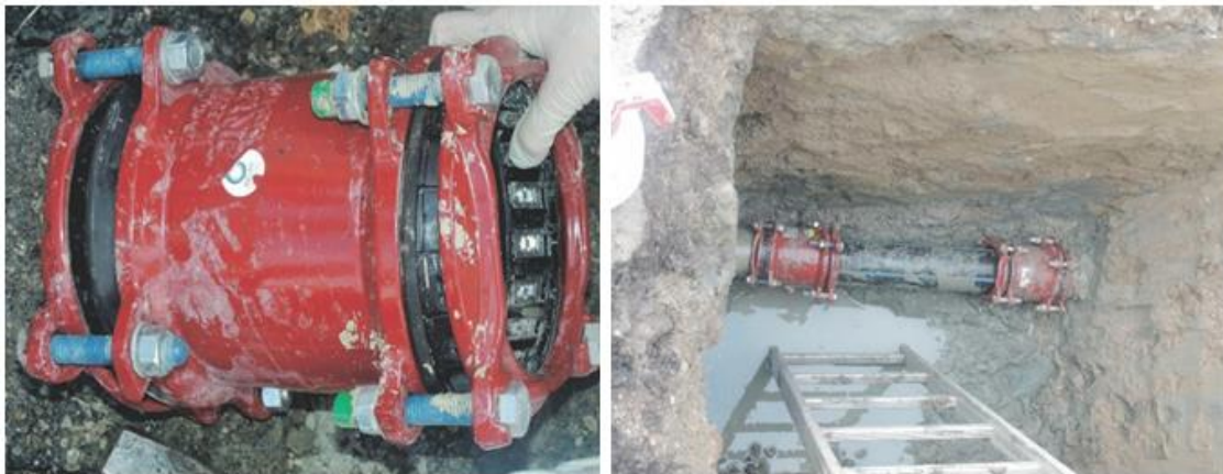
- Particolare del giunto di collegamento (sinistra); tratto di tubazione nuova in sostituzione di quella ammalorata (destra).
