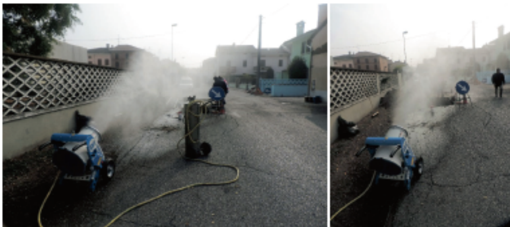
Figura 5 - Cannone nebulizzatore nell'area d'intervento.
